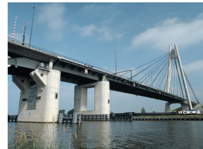
跳開橋と吊橋
